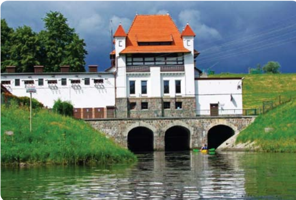
Elektrownia wodna w Straszynie
